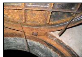
マンホール立ち上がりなし パッキンの破損
