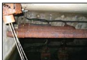
水槽内天井部に排水管設置
