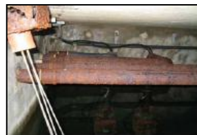
水槽内天井部に排水管設置
