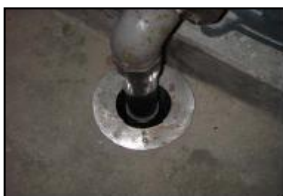
揚水管の隙間
