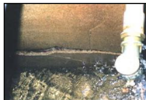
水槽内壁に亀裂あり
