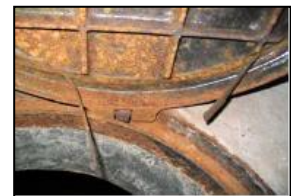
マンホール立ち上がりなし パッキンの破損
