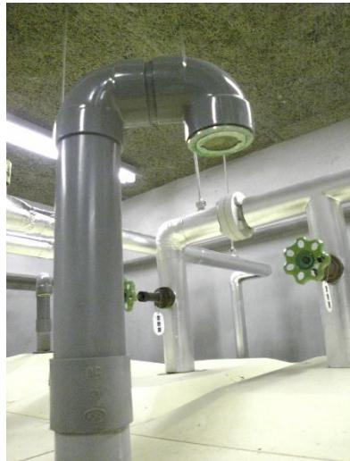
管を立ち上げてエルボ返し（十分な下り幅を設ける）する。その際、管端部に虫等の侵入を防ぐのに十分な網目の防虫網を取り付ける。網目の大きさは12メッシュ以上（約2mm目以下）が望まれる。または、既製品の通気管に更新する。
