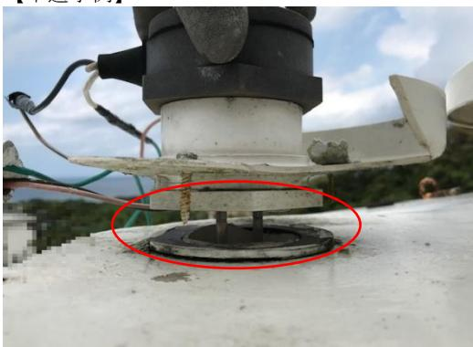
水槽上部と水位電極部との接合部が固定されておらず、水槽内に雨水等が流入するおそれがある。
