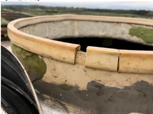
マンホール受け枠のパッキンが欠損し、防水密閉できていない。
