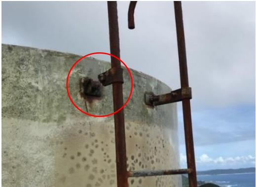
水槽本体梯子が腐食、破損し、点検、清掃、修理等に支障がある。
