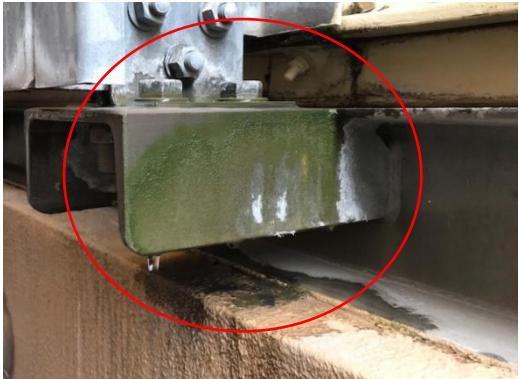
水槽下部のパネル接合部から漏水している。
