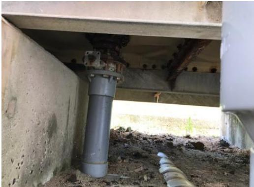
管端部が土中の排水設備に直接連結されている状況。
