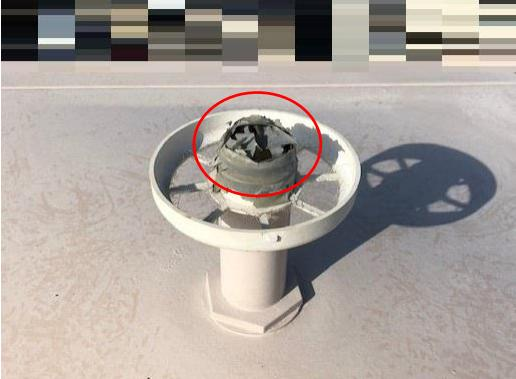
通気笠が無く、水槽内にはほこりその他衛生上有害なものが入り込むおそれがある。（管端部には過去にビニールテープにて補修した跡が見られるが、ビニールテープも劣化し、破損している）
