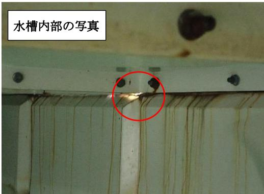
水槽上部のパネル接合部に隙間があり、水槽内に雨水等が流入する恐れがある。
