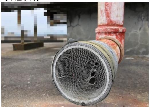
管端部の防虫網が破損し、水槽内に虫等が侵入するおそれがある。
