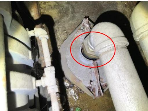
非告示型（地下式）水槽において、水槽上部にあるサクションユニットの揚水管挿入部に隙間が生じており、ほこりその他衛生上有害なものが入り込むおそれがある。
