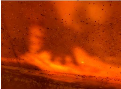
水槽の外壁塗装の劣化により水槽内に光が透過しており残留塩素濃度の低下や水槽内に藻類が発生するおそれがある。
