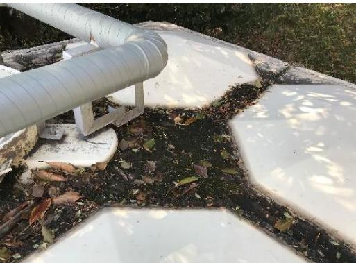
水槽の上床盤に勾配がなく、落葉等が堆積し、不衛生となっている。
