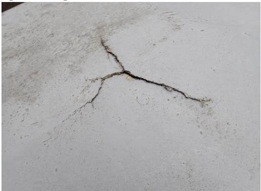
水槽本体（上部）に亀裂が生じ、水槽内に雨水等が流入する恐れがある。
