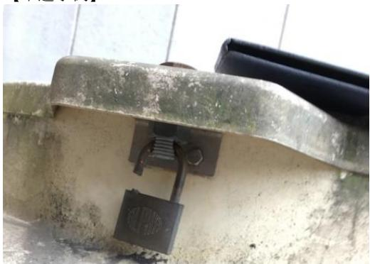
マンホールの南京錠が破損し、点検等を行う者以外の者が容易に開閉できる。
