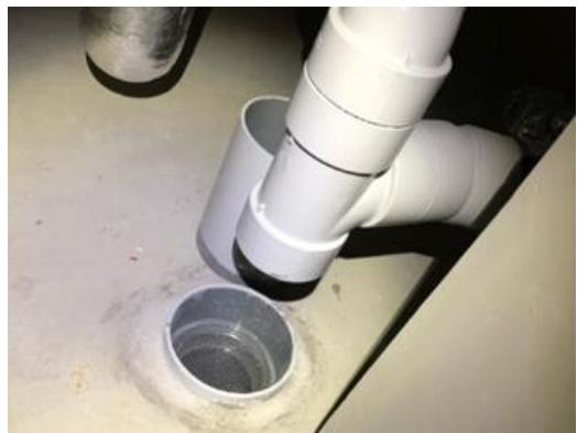
排水設備の受け口を切断し十分な排水口空間を確保する。
