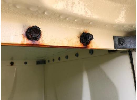
水槽内天井部のパネル接合部のボルト・ナットにかなりの腐食が見られる。
