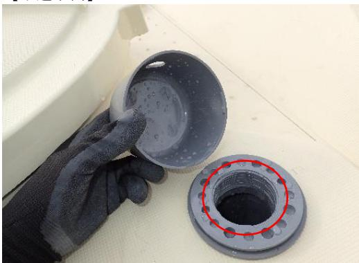
水槽上部に未使用の水位電極孔があり、水槽内に雨水等が流入するおそれがある。
